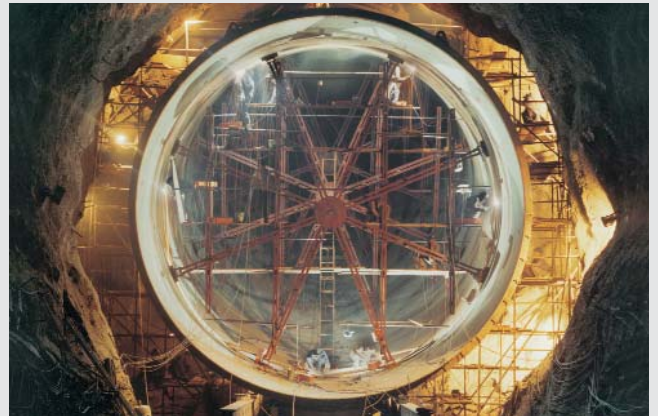
Druckrohrleitung/Penstock, Ertan Hydroelectric power plant / China
