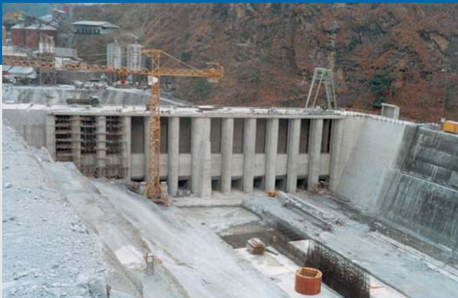
KW Einlauf – Power Intake
