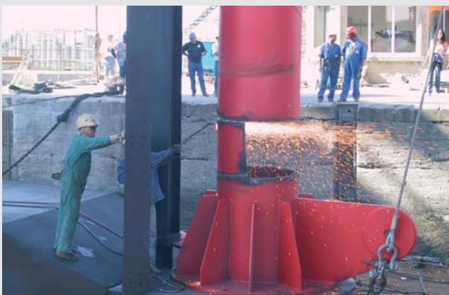
Ausbrennen Stütze – Flame cutting of support beam
