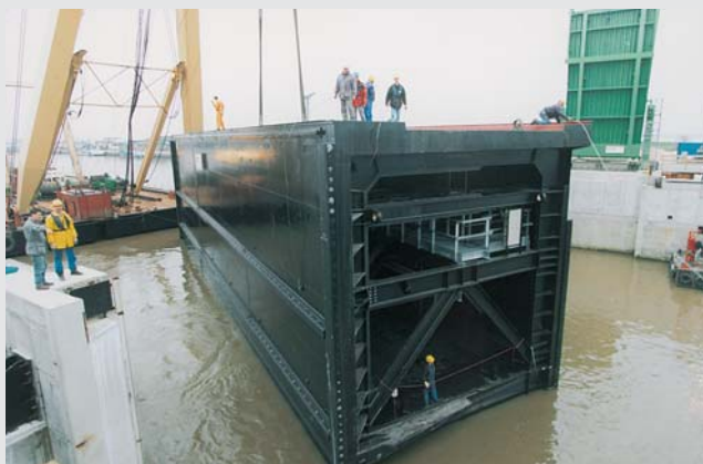
Einschwimmen - Floating in position
