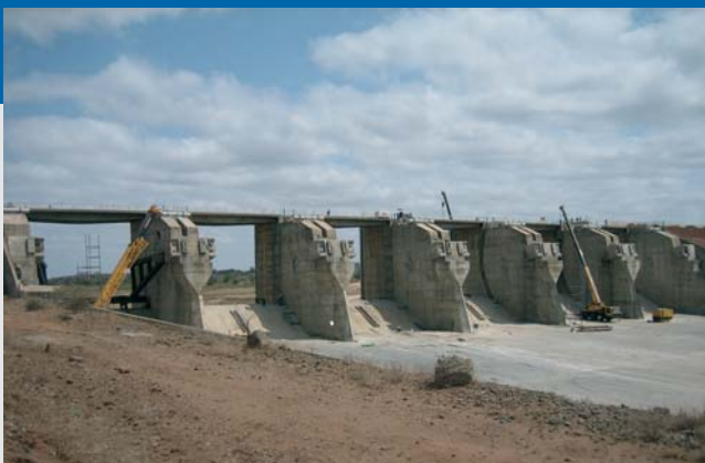
Hochwasserentlastung - Spillway
