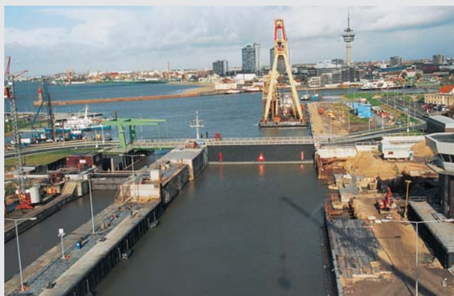
Schleusekammer - Lock chamber
