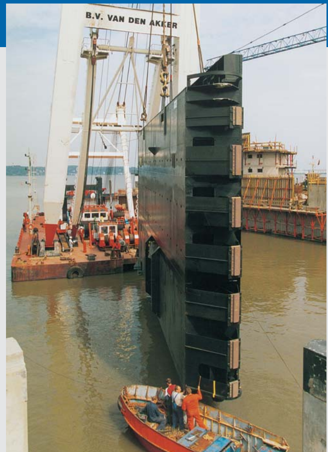
Einheben Stemmtor - Placing of Mitre Gate
